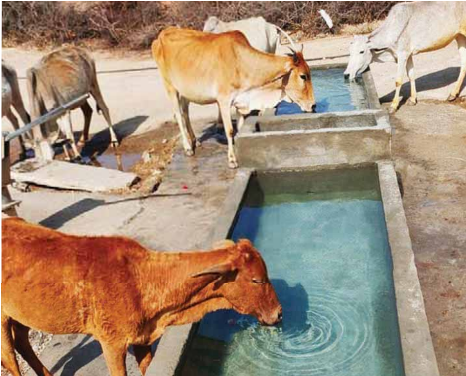
ಜಾನುವಾರು ತೊಟ್ಟಿಯ ಸಾಮಾನ್ಯ ಗಾತ್ರ: 7 ಮೀ. x 1.5 ಮೀ. x 0.6 ಮೀ., ದನಗಳ ತೊಟ್ಟಿಯ ಸಣ್ಣ ಗಾತ್ರ: 3 ಮೀ. x 1.5 ಮೀ. x 0.6 ಮೀ.
